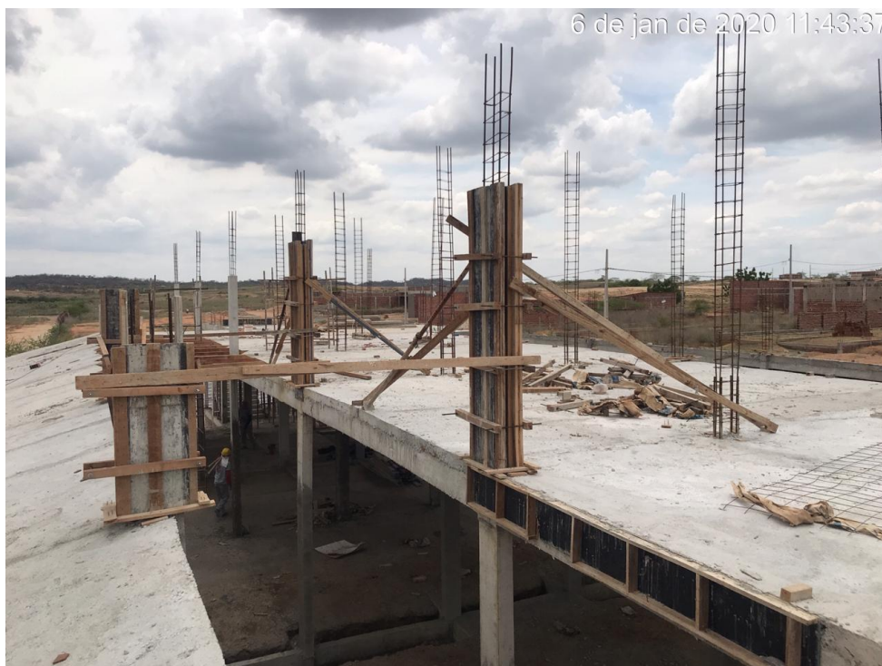
Foto 06 – 1º andar – Início dos pilares
