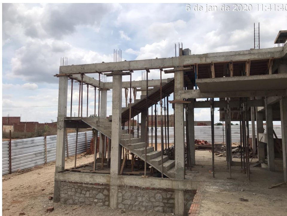
Foto 04 – Escada em concreto armado
