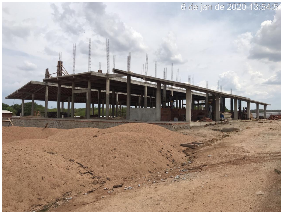
Foto 01 – Vista panorâmica da obra
