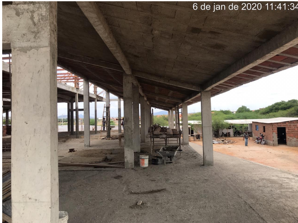
Foto 05 – Pilares e laje em concreto armado
