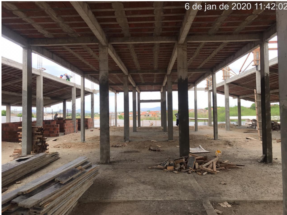
Foto 03 – Vista interna, estrutura de concreto armado
