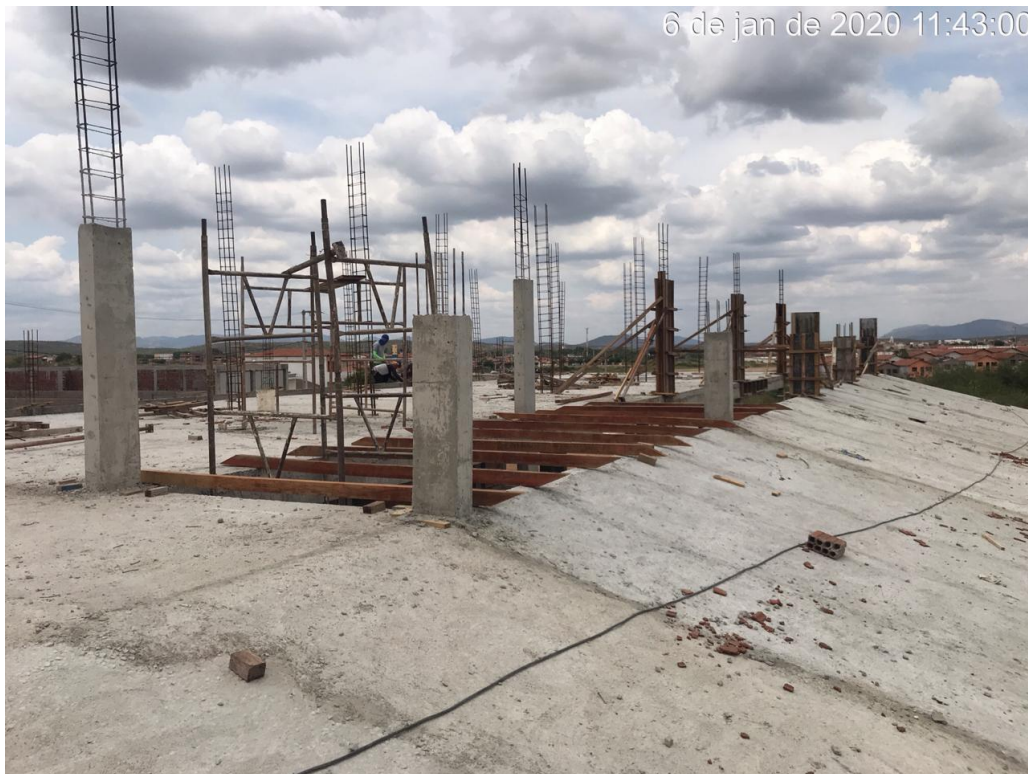
Foto 07 – 1º andar – Início dos pilares
