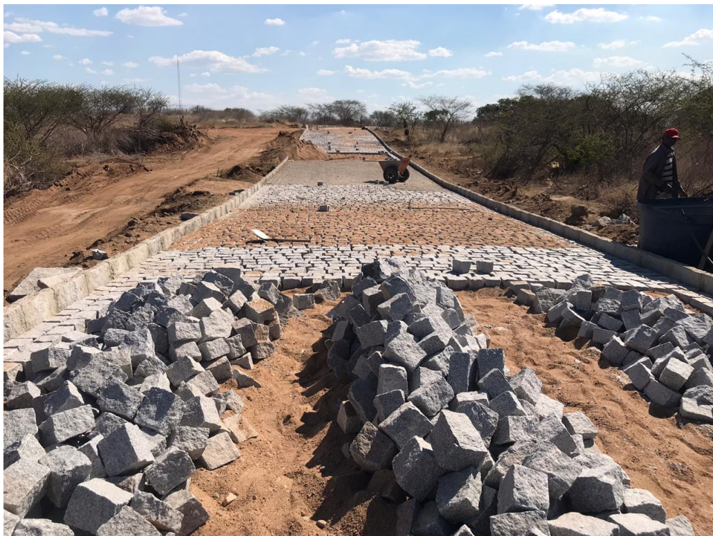
Foto 08 – Pavimentação de acesso a edificação
