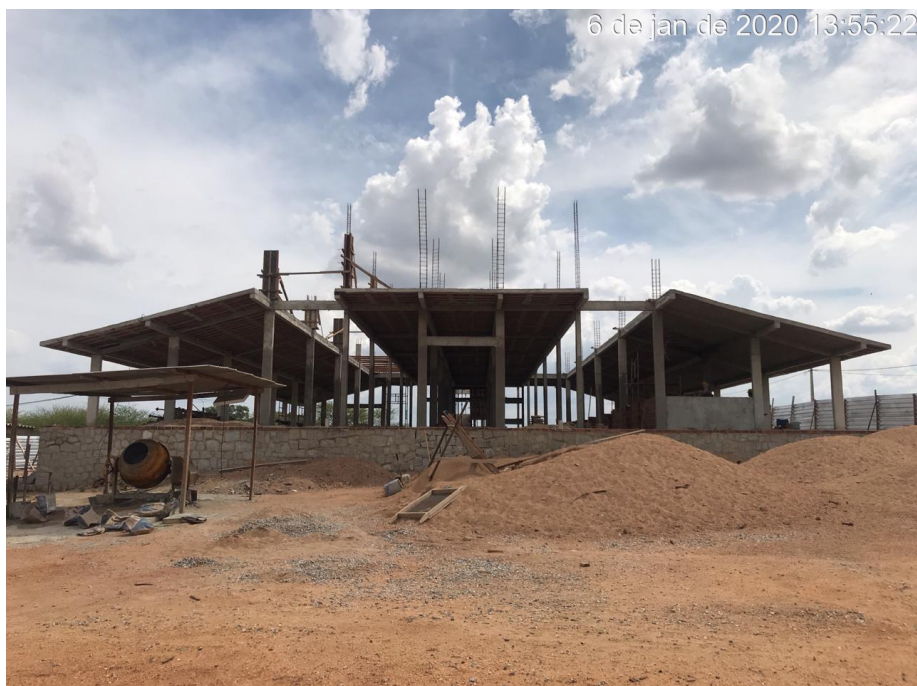
Foto 02 – Vista panorâmica da obra
